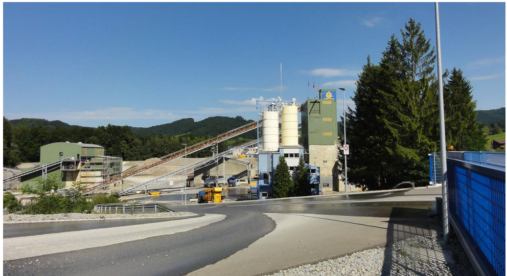
Abb. 11 Bestehende Aufbereitungsanlage, Ansicht aus Südwesten (Quelle: Gruner)
