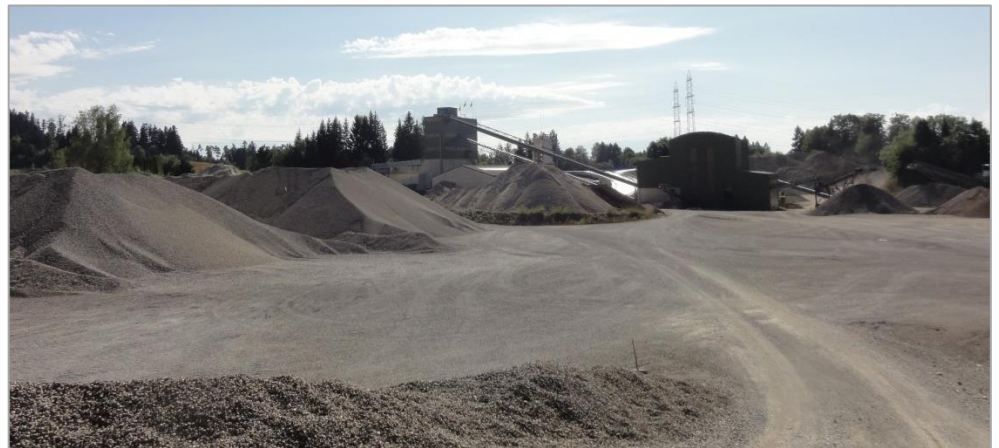
Abb. 13 Bestehende Aufbereitungsanlage, Ansicht aus Nordosten (Quelle: Gruner)
